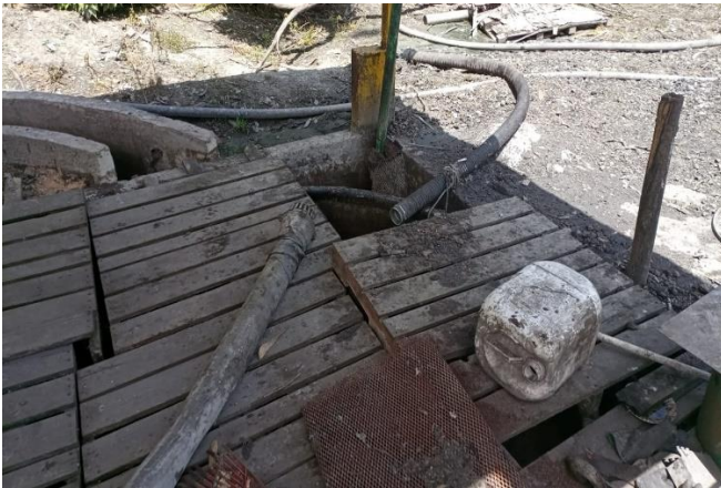
Rejillas en el area de secada conectadas al tanque de lixiviados de este proceso.
