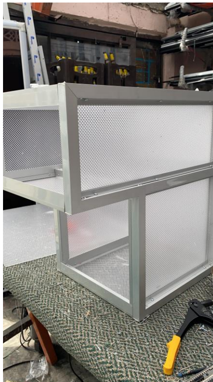
Figura 15. Estructura en proceso de finalización de su construcción.
