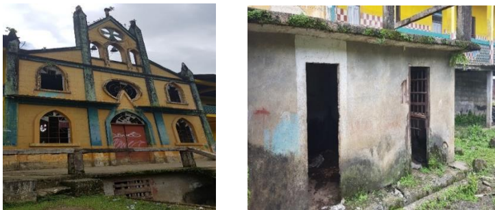
Ilustración 1 Detalle Iglesia del ex internado de Aguasal y la cárcel
