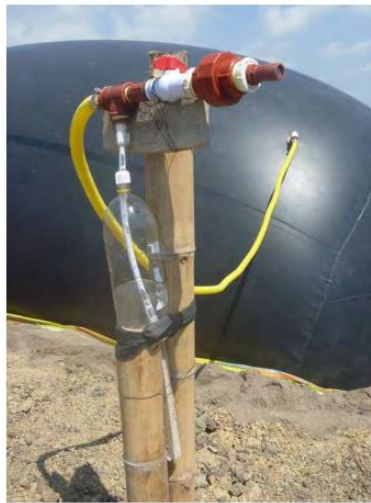
Figura 31. Válvula de alivio.
