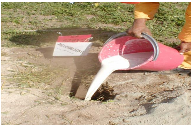
Foto N° 7. Neutralización de pozo por incumplimiento de ubicación.
