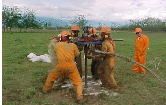
Fotografía N° 3. Perforación de pozos.
