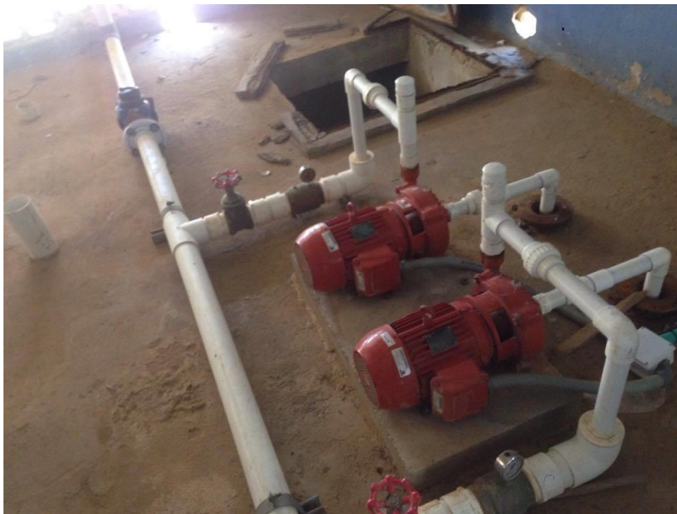
4.4 Modulo de ósmosis inversa
