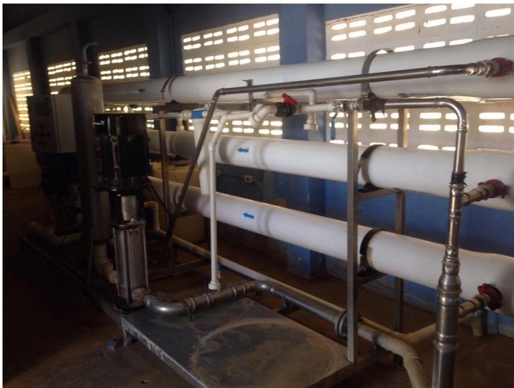
4.5 Membranas semi permeables del módulo de ósmosis inversa.
