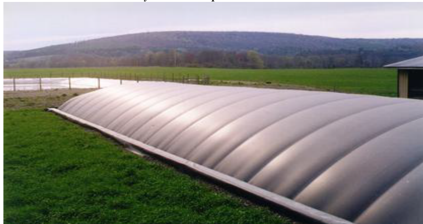
Imagen 10. Biodigestor de flujo continuo implementado en una finca de pequeña y mediana producción.
