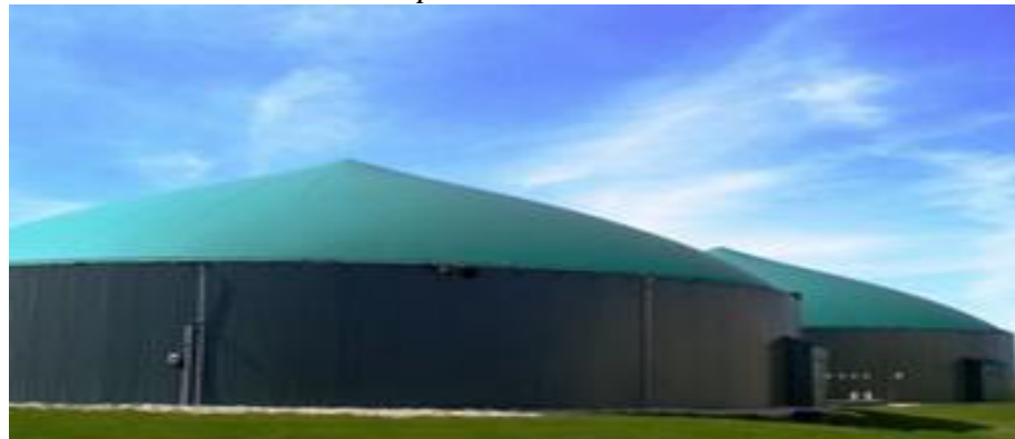
Imagen 11. Biodigestor de tipo mezcla completa implementado para una lechería de gran producción
