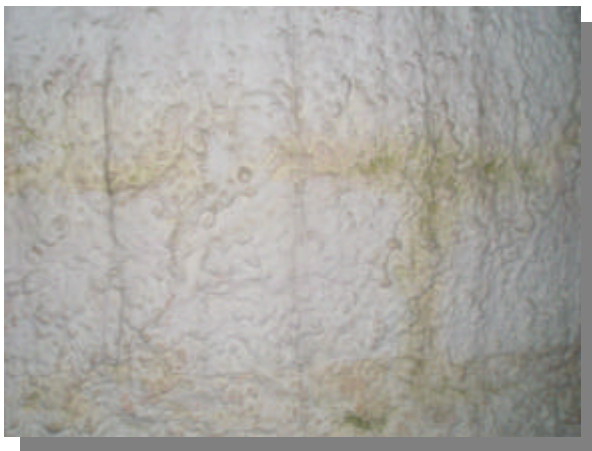
Figura 11 - Filtraciones
