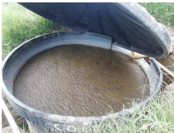
Figura 7. Tanque estercolero de 5000 litros.
