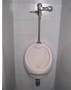
Figura 4, Orinal con dispositivo ahorrador
