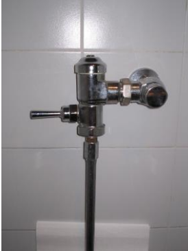
Figura 3, Fluxómetro tipo Royal modelo 186
