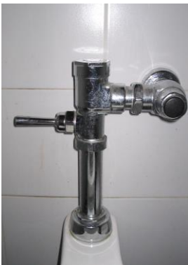
Figura 5, Fluxómetro tipo Royal modelo 180
