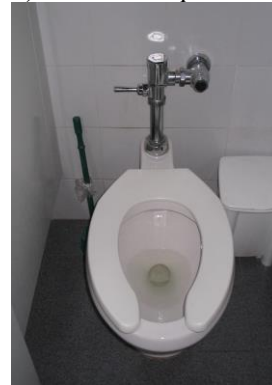
Figura 6, Sanitario con dispositivo ahorrador
