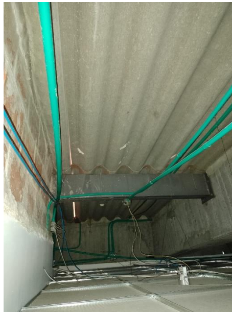
Figure 46 Estructura de cubierta Oficinas Constructora Bolívar
