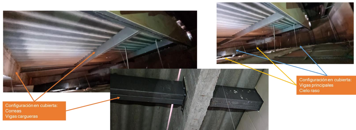
Figure 51 Tipo de teja, correas y carga en cubierta
