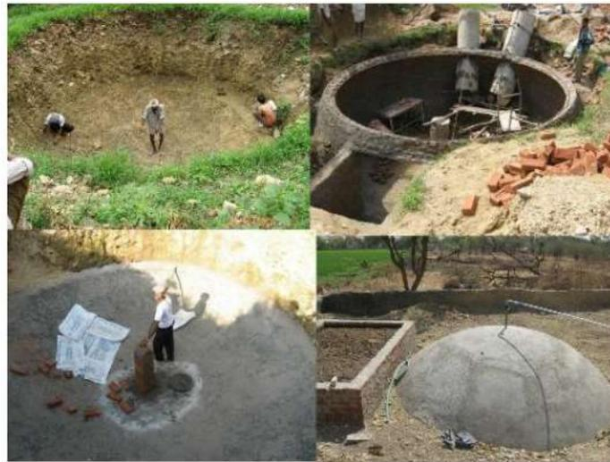
Figura 3738. Biodigestor cúpula fija. Fuente: (Rodriguez, 2014)
