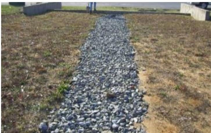
*Figura 13 Zanja de infiltración (Universidad de los Andes, 2017)*
