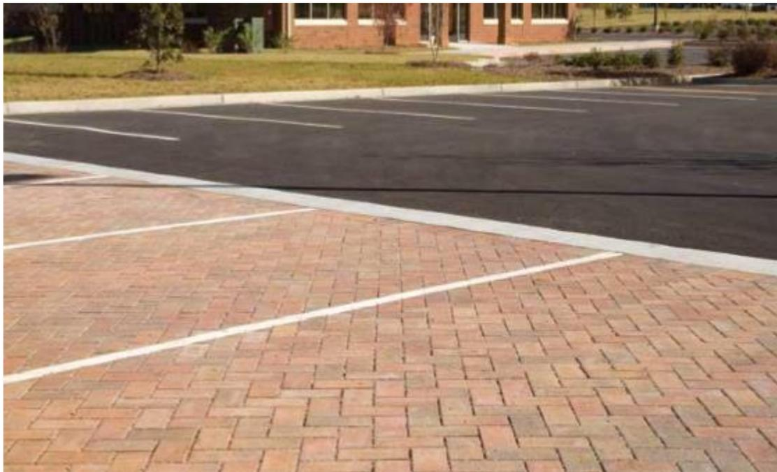
*Figura 10 Pavimentos permeables de tipo adoquines entrelazados (Universidad de los Andes, 2017)*
