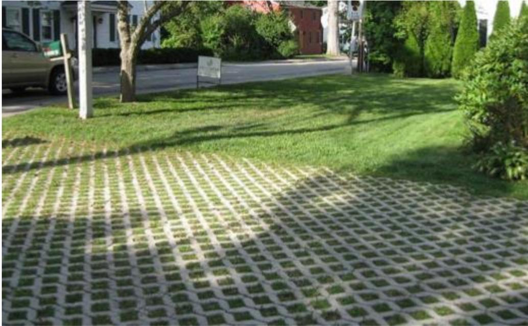
*Figura 11 Pavimentos permeables de tipo adoquines de rejillas de concreto (Universidad de los Andes, 2017).*
