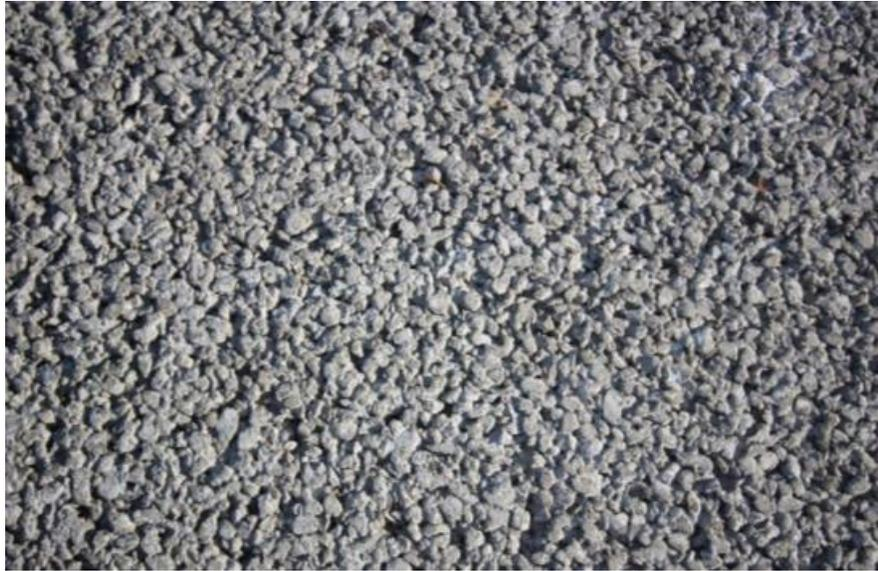
*Figura 9 Pavimento Permeable de tipo concreto poroso (Universidad de los Andes, 2017)*
