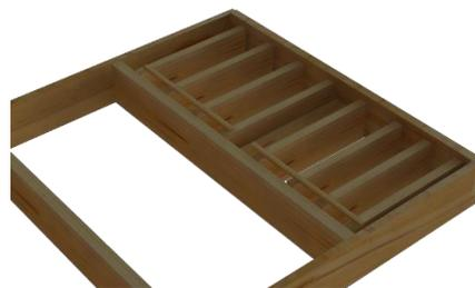
7. Para el recubrimiento del módulo de la mitad y el inferior, se corta la esterilla a la medida y se coloca entre dos palos para que no se salga
