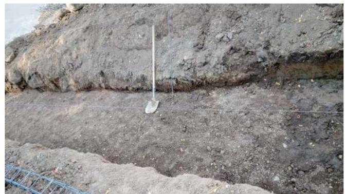
**Figura 15.** Nivelación del terreno excavado. Elaboración propia.
