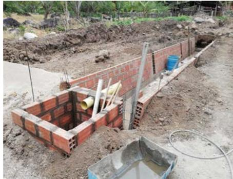
**Figura 20.** Instalación de tubos conductores y construcción de tanques afluente y efluente. Elaboración propia.
