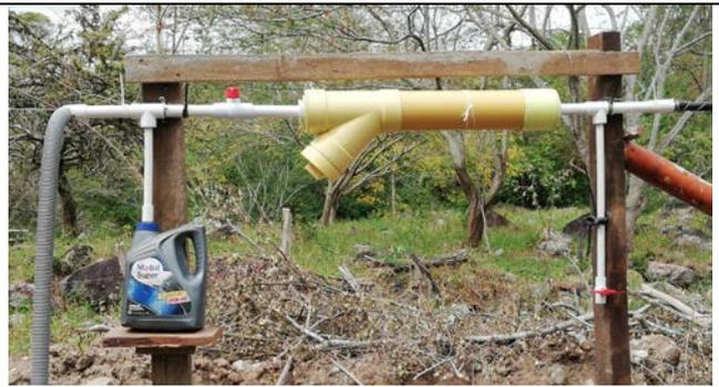
**Figura 30.** Trampa de gases instalada con sistema de válvulas, válvula de seguridad o sello hidráulico (regulador de presión). Elaboración propia.
