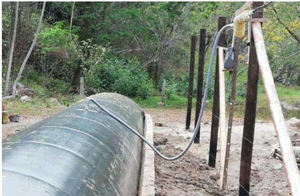
**Figura 31.** Conexión de geomembrana biodigestora al sistema de trampa de gases, por medio de manguera flex. Elaboración propia.
