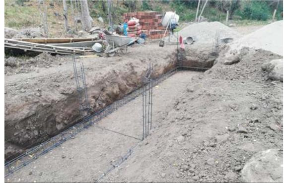
**Figura 16.** Instalación de refuerzos.
