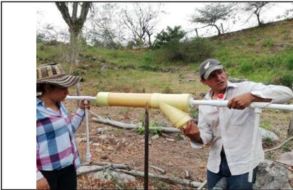
**Figura 29.** Seguro roscado de la trampa de gases. Elaboración propia.
