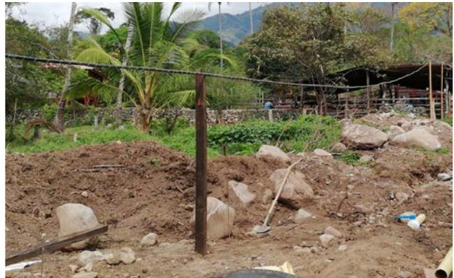
**Figura 32.** Red de conducción de biogás hacia el corral, con pendiente para retornar gas metano condensado. Elaboración propia.
