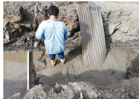
**Figura 17.** Vertido de concreto.
