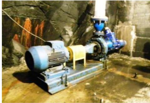
Bomba estacionaria ubicada en el sitio del tanque de rebombeo
