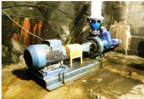
*Figura 2.* Bomba estacionaria ubicada en el sitio del tanque de rebombeo
