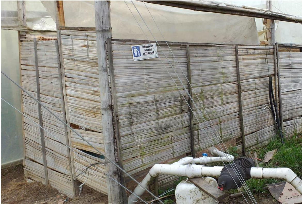
Figura 13. Construcción punto de acopio tipo enramada
