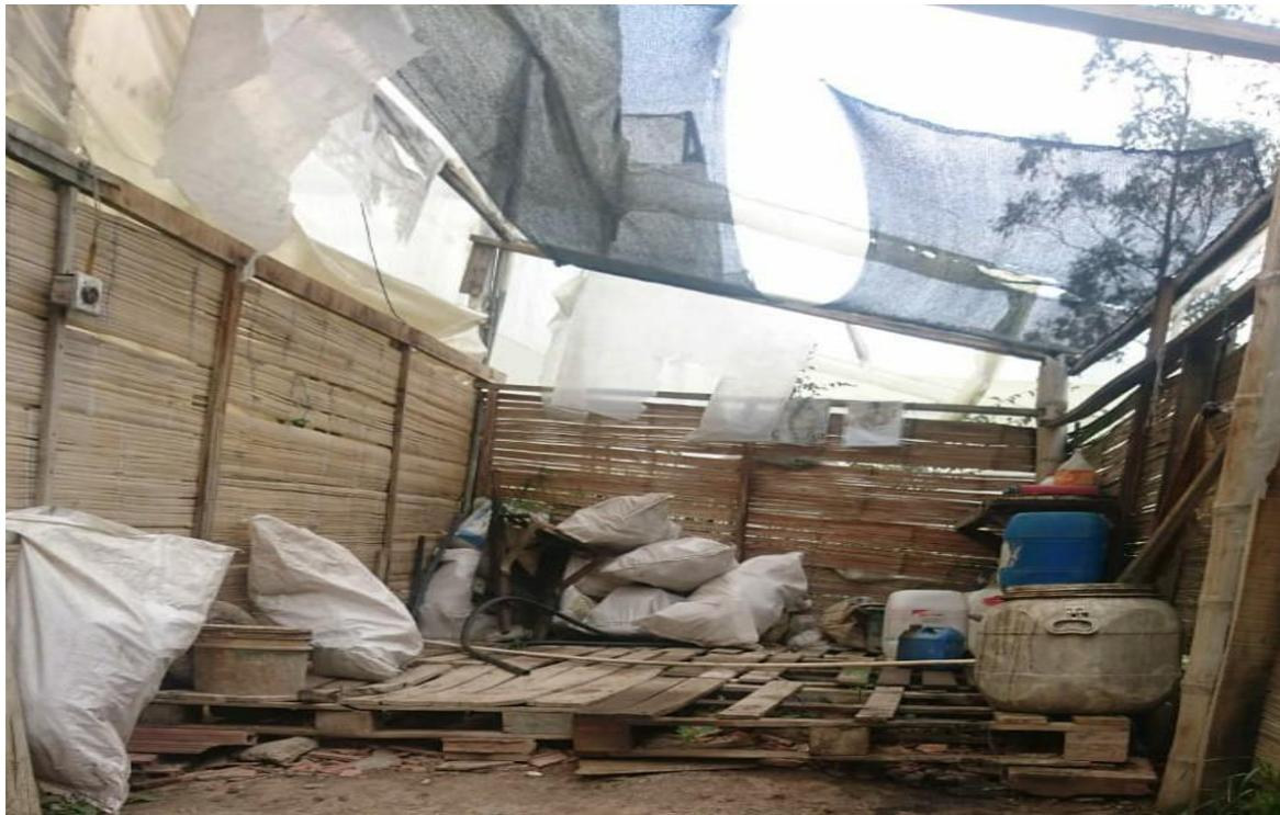
Figura 14. Techo con presencia de roturas
