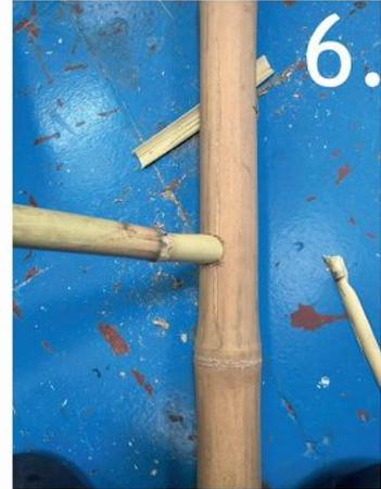
Generar los vacíos necesarios sobre los ejes horizontales para ensamblar la caña brava estructural.
